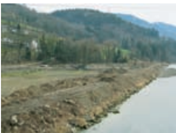
Bauarbeiten am Damm in Schildried
