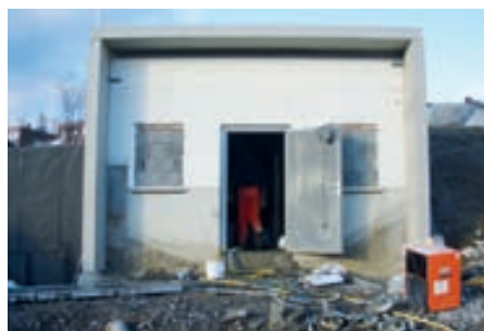
Die Sanierung des Hochbehälters Pofel am Pofelweg.
