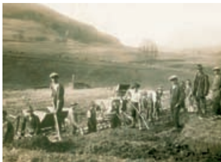
Straßenbau Richtung Dums, im Hintergrund das noch unverbaute Badida
