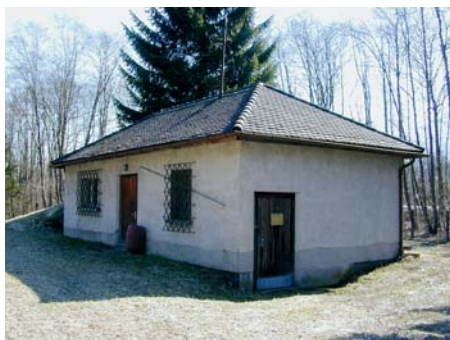
Erstes Pumphaus in Schildried, abgetragen nach dem Hochwasser im Jahr 2005
