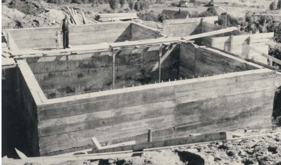
Bau des Hochbehälters Pofel
