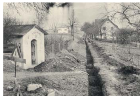
Grabungsarbeiten an der Badidastraße
