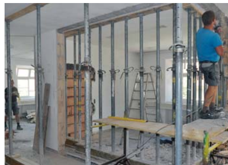
Mitarbeiter des Gemeindebauhofes bei den Abbrucharbeiten
