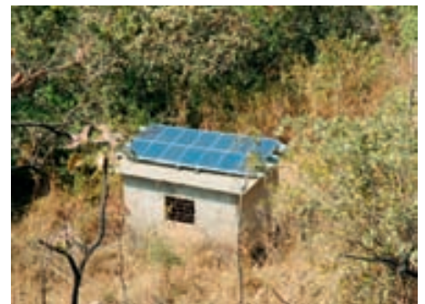
Pumpenhaus mit Solarpaneelen
