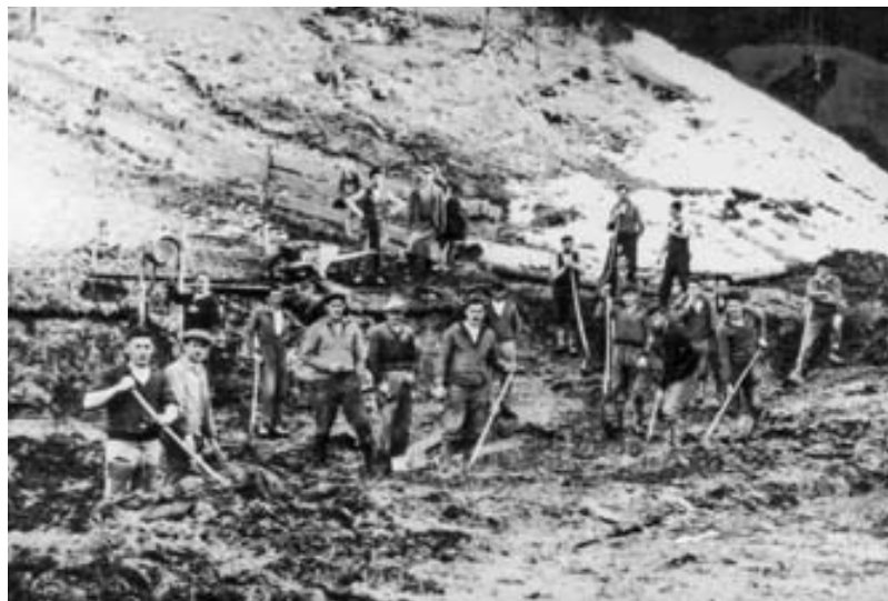
Arbeiten an der Wasserleitung im Jahre 1935
