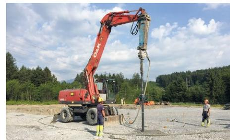
Aufgrund der Bodensituation musste pilotiert werden. Derzeit wird die Bodenplatte gefertigt.
