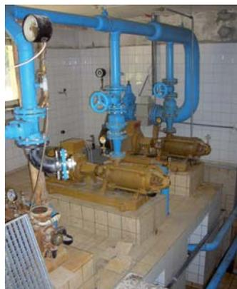
Der Grundwasserbrunnen Schildried mit den Pumpen und der Steuerungsanlage wurden durch das Hochwasser zerstört. Das Wasserwerk wird abgerissen und der neue Brunnen mit der Pumpanlage hochwassersicher errichtet.
