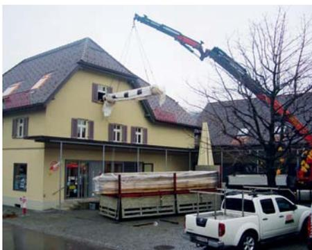
Da das alte Konsumgebäude statisch nicht den heutigen Anforderungen entsprach, mussten im Vorfeld der gesamte Dachstuhl verstärkt und die Last des Dachstuhles auf die Außenwände umgeleitet werden. Dazu wurden mehrere Stahlträger im Bodenbereich eingezogen. Ebenso musste der gesamte Ausbaubereich mit einer entsprechenden Innendämmung ausgestattet werden.
