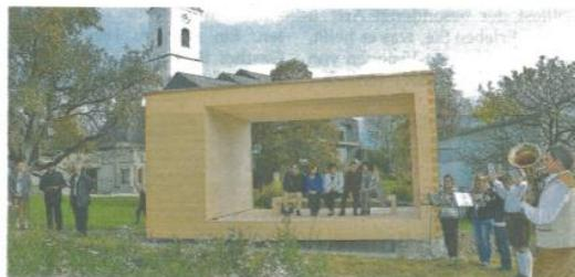
Gölfner Architektin DI Sonja Entner geplant. Die Umsetzung des Baus in Holzstrickbauweise mit heimischen Holz und grundsätzlich ohne die Verwendung von Nägeln und Schrauben zeigt eine fast vergessene jahrhundertalte Tradition des Holzbaus.
